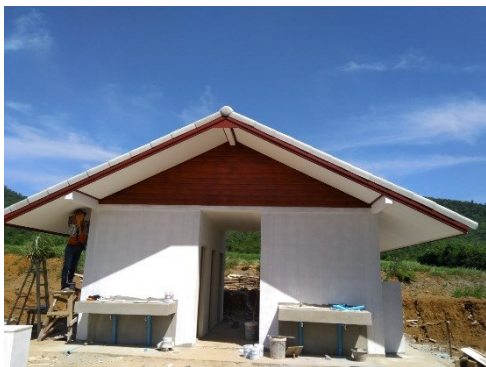
งานอาคารห้องน้ำ - ห้องสุขา ขนาด ๒๔ ตารางเมตร จำนวน ๑ แห่ง
